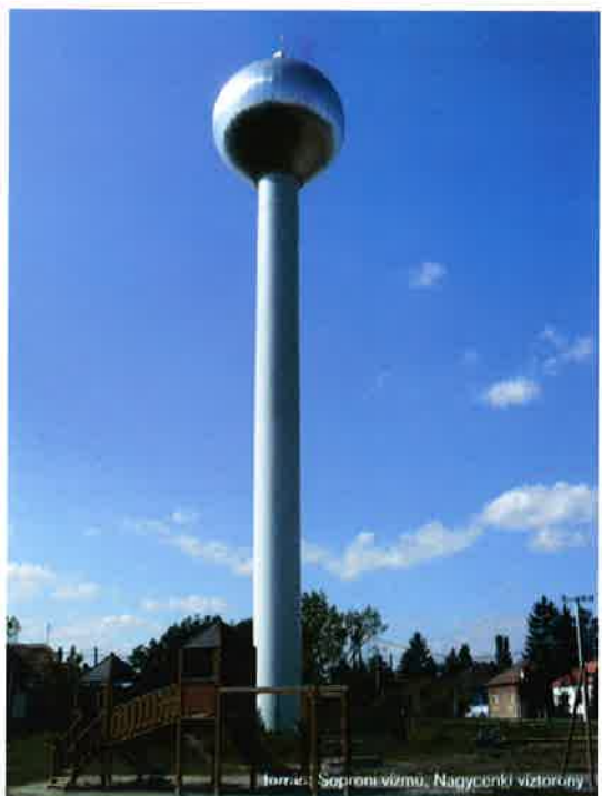
Forrás: Soproni vízmű, Nagycenkői víztorny
