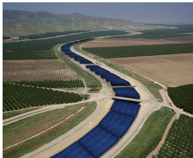
Csatorna fölött elhelyezett napelemek
