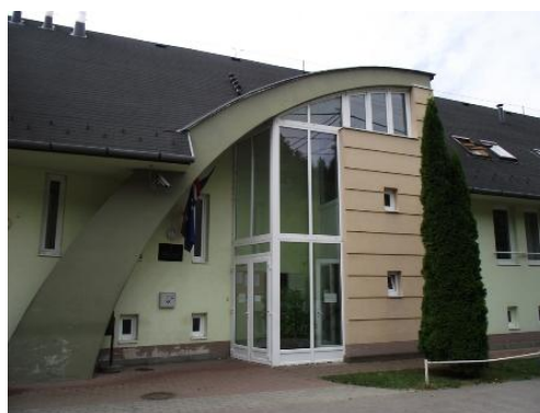
3100 Salgótarján, Karancs út 54. szám alatti épület
